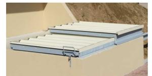
8m2 de panneaux installés sur la toiture pour les besoins de lavage des camions
